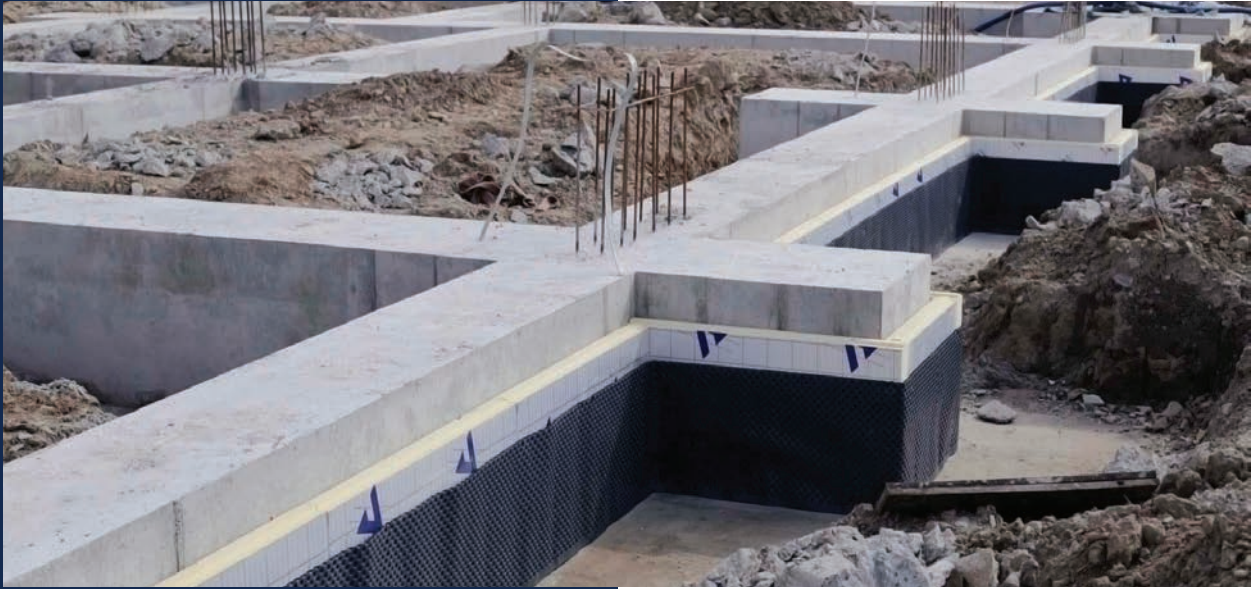
Alapok szigetelése termPIR® táblákkal
